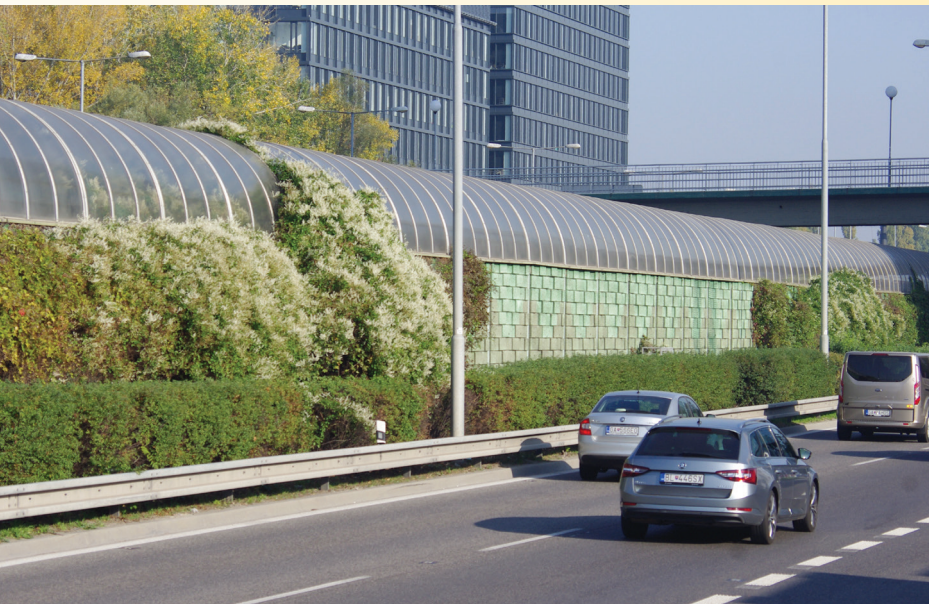
Obr. 5. Protihlukové bariéry sú jedným z najbežnejších opatrení na zníženie hlukovej záťaže prostredia
